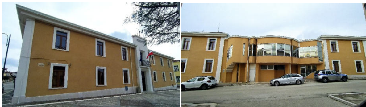
Facciate ovest ed est del Municipio di Aquilonia
